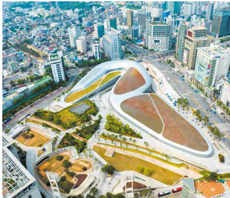
Внешнее покрытие комплекса состоит из 45 тысяч металлических панелей различной кривизны
